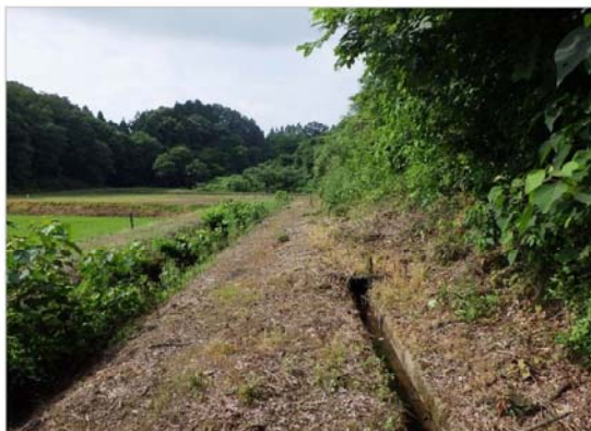
下流部上流側より
